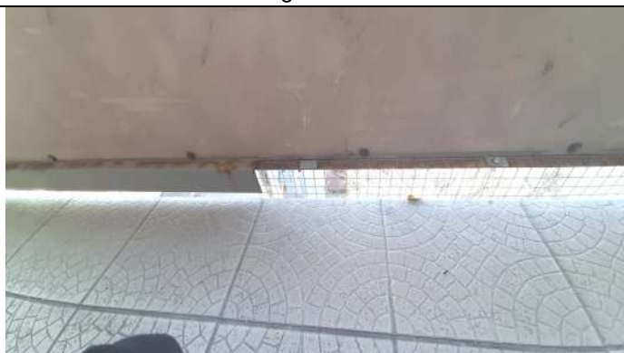
Fot. 20. Lokalna wymiana skorodowanego kołnierza z blachy na kratkę ze stali nierdzewnej
