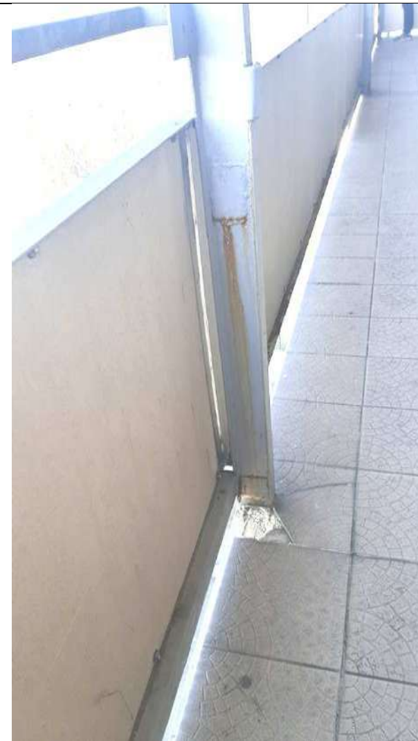
Fot. 12. Uszkodzenia i odspojenie płytek na styku słupa i posadzki, zacieki spod "łaty" przyspawanej do środka słupa.
