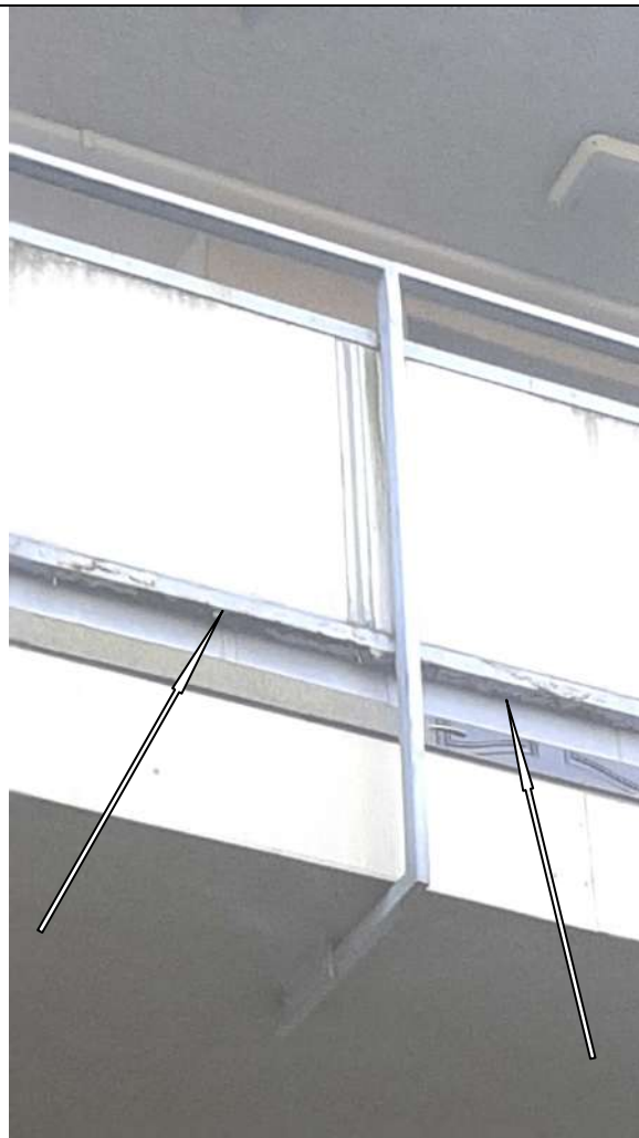
Fot. 11. Zacieki i uszkodzenia korozyjne obramowań balustrad - widok od zewnątrz.
