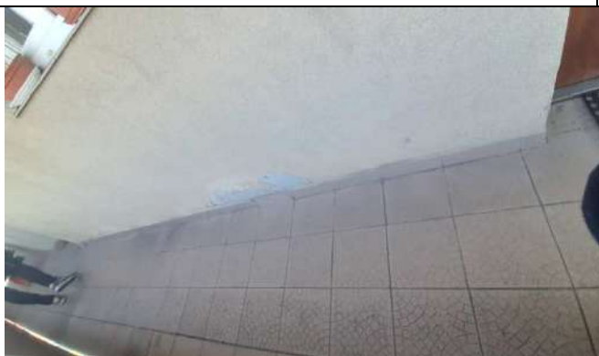
Fot. 21. Uszkodzenia tynku cienkowarstwowego i odspojone płytki cokołu.
