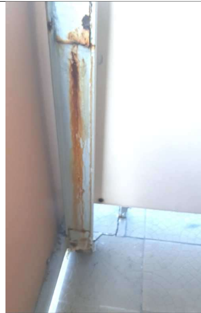
Fot. 28. Uszkodzenia korozyjne słupka i posadzki na galerii - ostatnie pole od strony ul. Zofii Chrzanowskiej.
