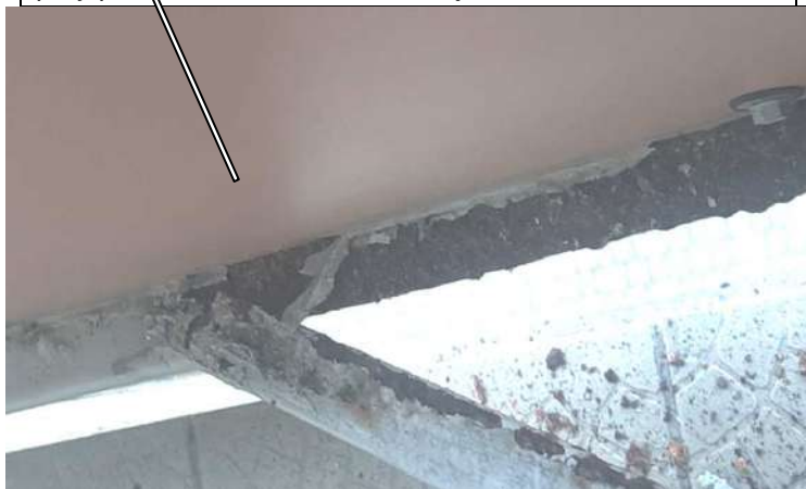
Fot. 13. Uszkodzenia korozyjne obramowań balustrad przy posadzce - widok od wewnątrz
