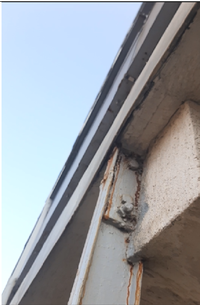
Fot. 10. Styk kompensacyjny słupa mocującego balustradę - II p..
