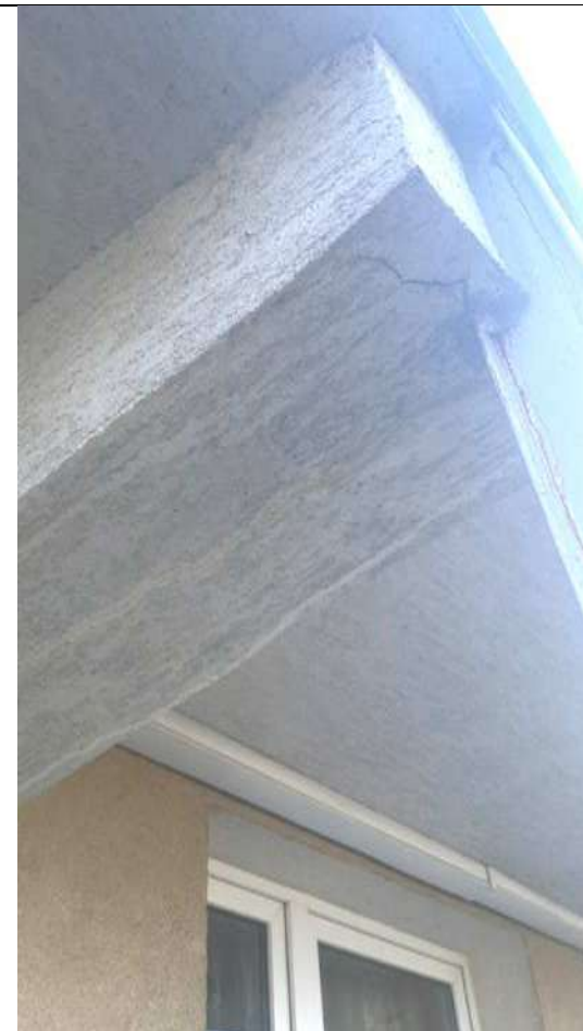
Fot. 6. Przykład uszkodzenia czoła wspornika żelbetowego konstrukcji wsporczej galerii c.d.
