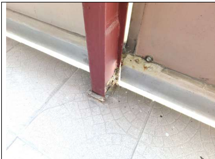
Fot. 18. Uszkodzenia korozyjne słupa przy posadzce galerii.
