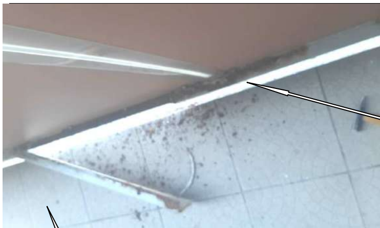
Fot. 13. Uszkodzenia korozyjne obramowań balustrad przy posadzce - widok od wewnątrz
