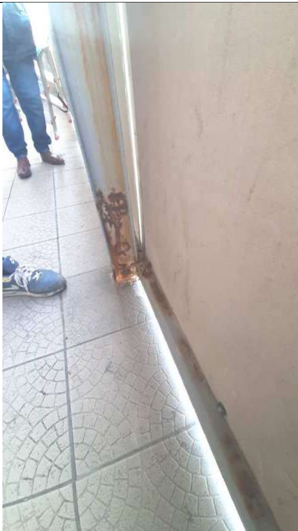
Fot. 26. Inny przykład korozji słupka i dolnej krawędzi obramowania balustrady.
