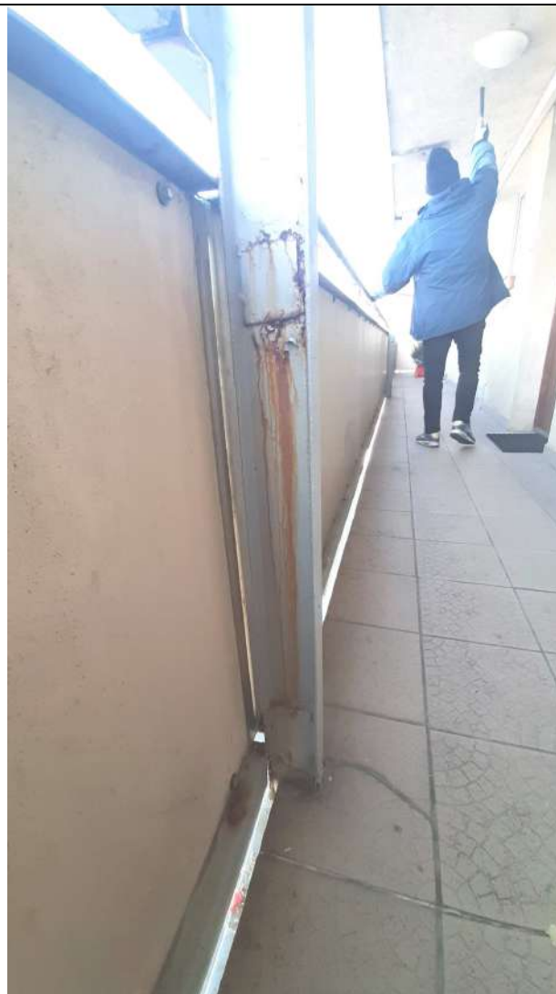
Fot. 27. Przykładowa korozja w w obszarze naspawanej "łaty" na słupku mocującym balustradę.
